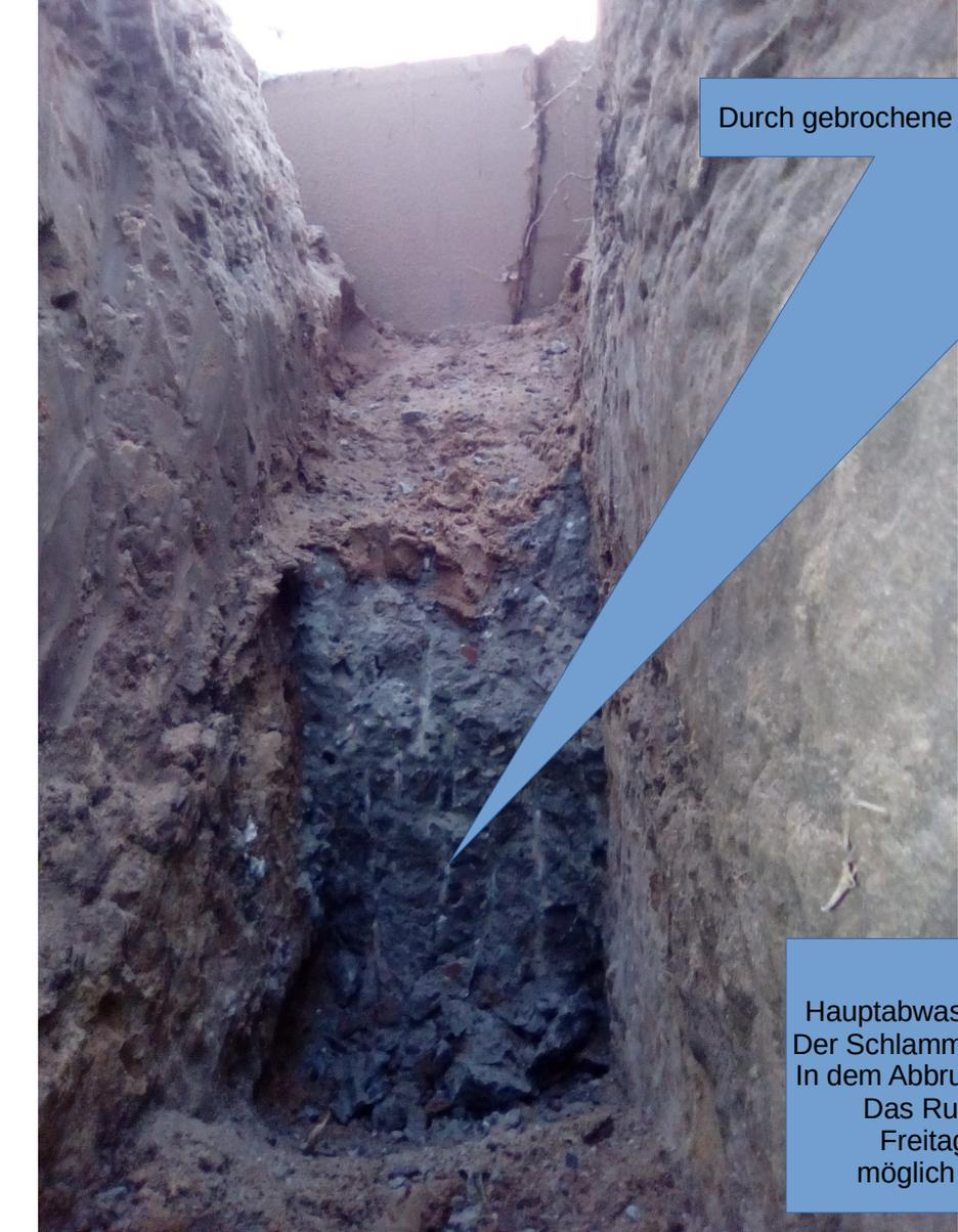
Durch gebrochene Schalung zubetoniertes Abflußrohr per Hand wieder freilegen
